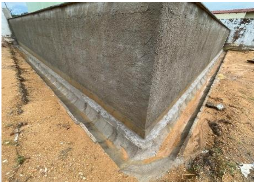
Imagem 05: canaleta de drenagem pré-moldada;
