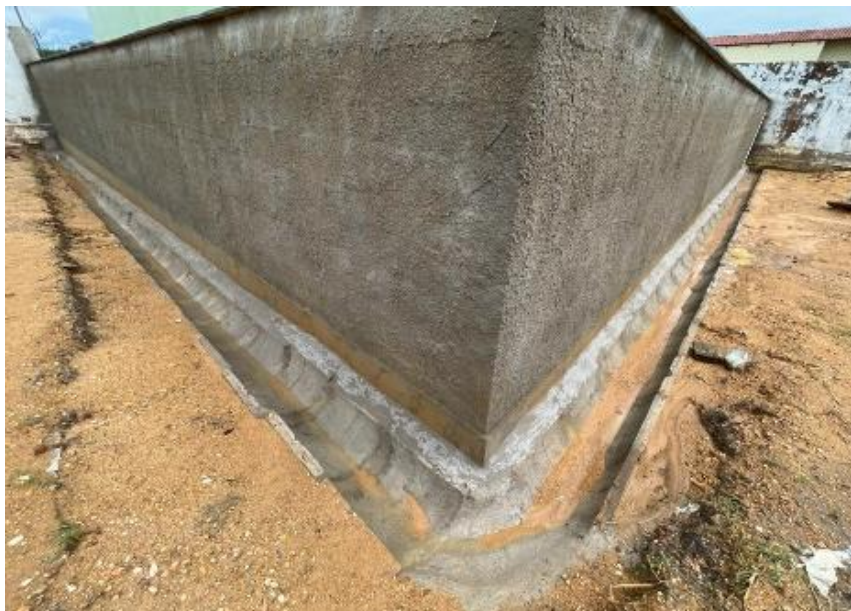
Imagem 05: canaleta de drenagem pré-moldada;
