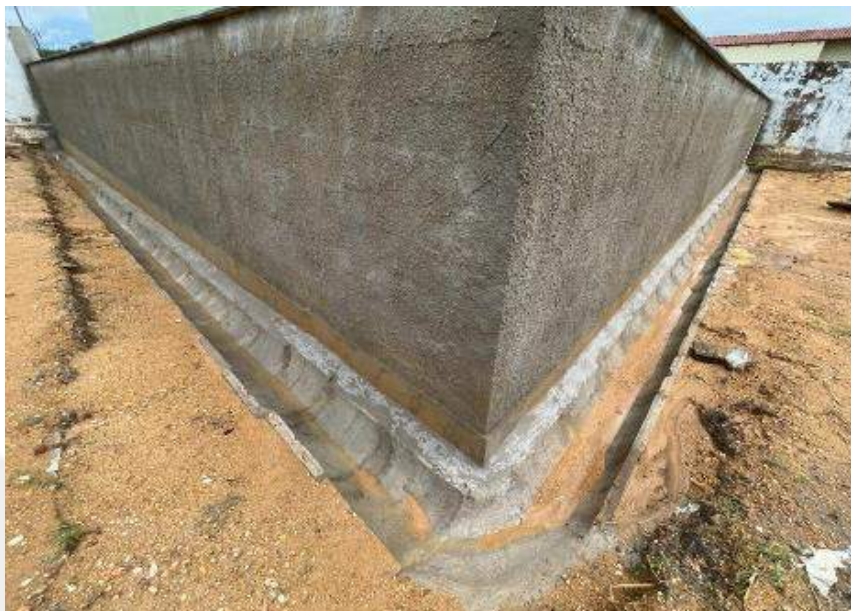
Imagem 05: canaleta de drenagem pré-moldada;
