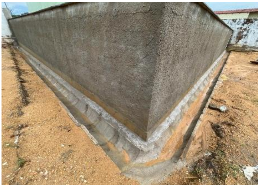
Imagem 05: canaleta de drenagem pré-moldada;
