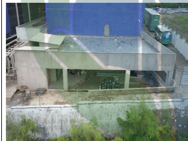
Imagem 7. Fachada Leste – Ampliação bloco A;
