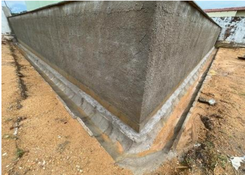
Imagem 05: canaleta de drenagem pré-moldada;
