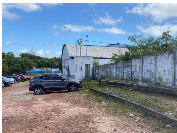
Vista interna - terreno
